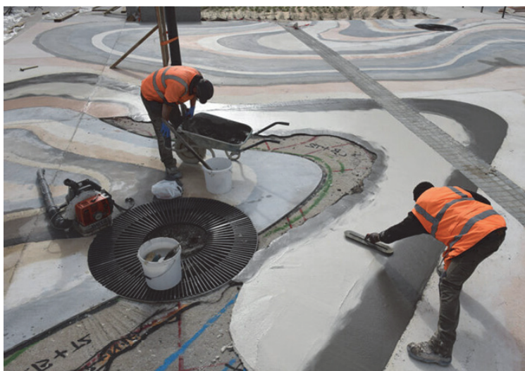
Etape de coulage du béton, place du Général de Gaulle, Ivry-sur-Seine, 2015.
